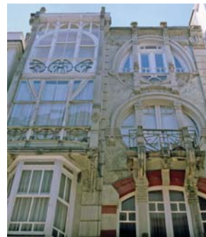
Casa Pereira Unha orixinal resolución de galerías e balcóns, xunto cos novos materiais construtivos de ferro e de cemento.
